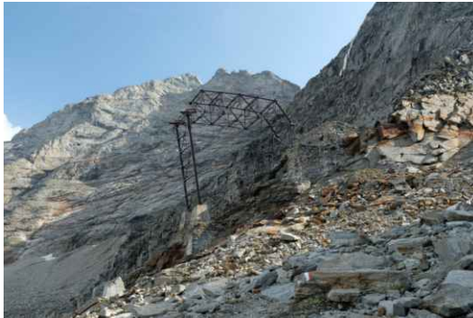
Gestell der Seilbahn zum Abtransport des Erzes.
