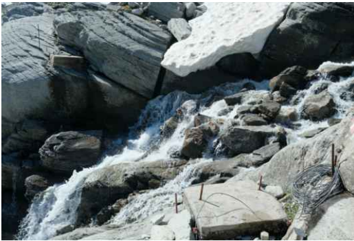
da fehlt die Brücke
